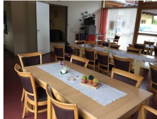
Lichtschalter nicht visuell kontrastreich
